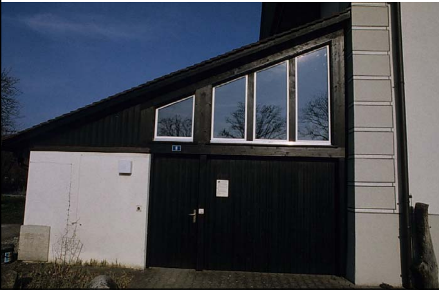
1997 Ausbau Estrich, weitere Fenster Vorbau, P
