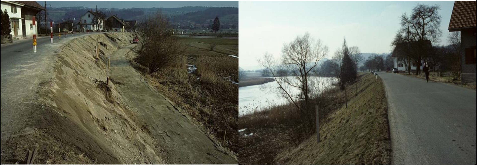
Ausbau Kantonsstrasse in Rottenschwil 1981
