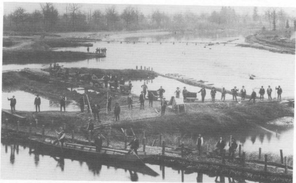
Das Fachen. Ufer und Dämme wurden durch Faschinezäune befestigt und höher aufgeschüttet. Die dazwischen entstandenen Gruben sind heute noch zu sehen. Im Vordergrund die Lorze, hinten die Reuss.
