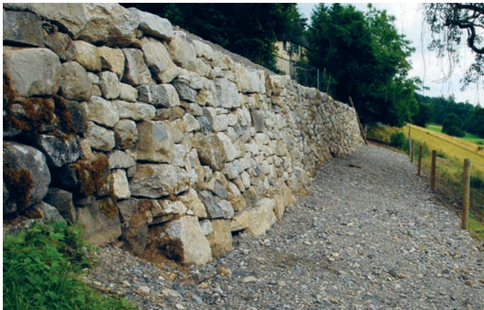
Restaurierte, komplett neu aufgebaute Bruchsteinmauer im Grossberg Oberrohrdorf
