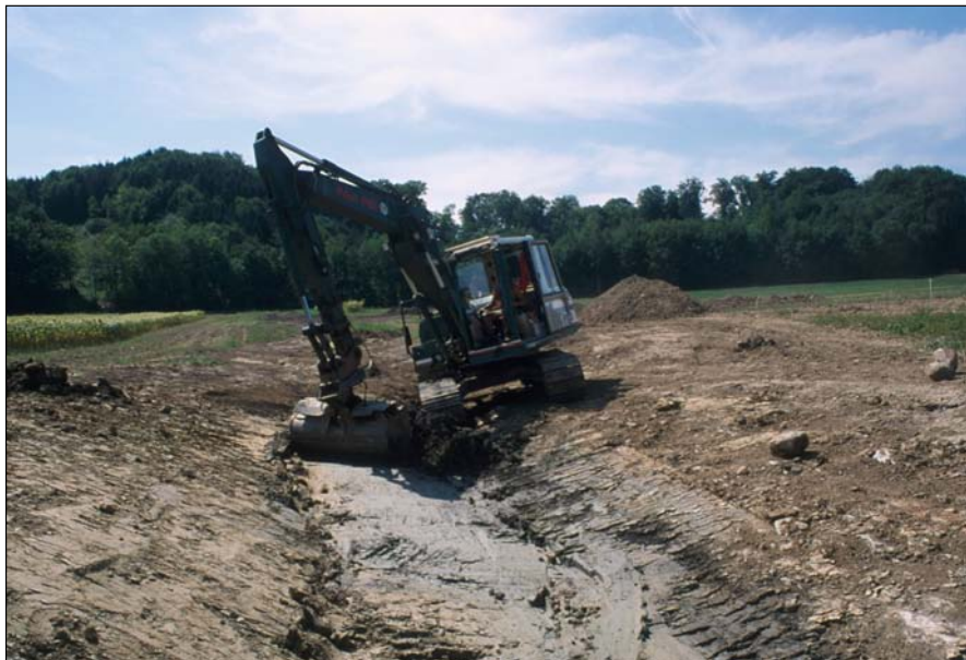
Das Bachbett für den neuen Tüüflibach wird angelegt, August 2003
