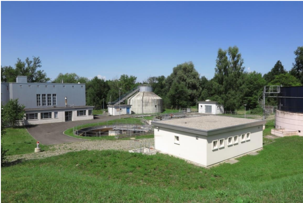
Die stillgelegte Abwasserreinigungsanlage (ARA) Ottenbach Jonen (Aufnahme Juli 2017)
