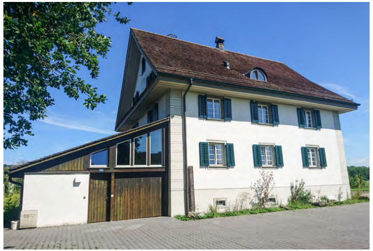
Das Zieglerhaus vor der Renovation 1979 und heute.
