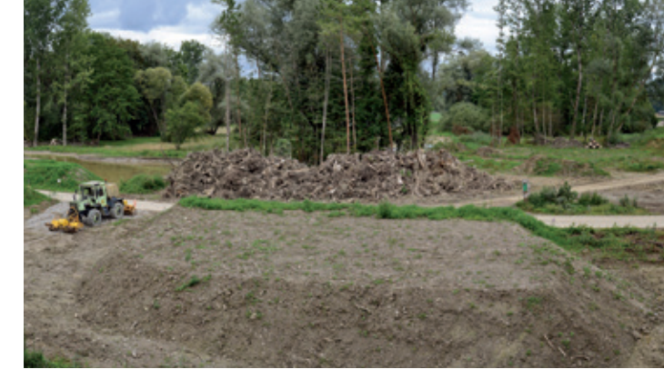
Rund 200 000 m 3 Aushub: Renaturierung des Chly Rhy, Rietheim, 2014/2015
