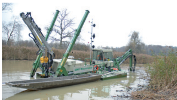
Stillgewässersanierung im Moos, Rottenschwil
