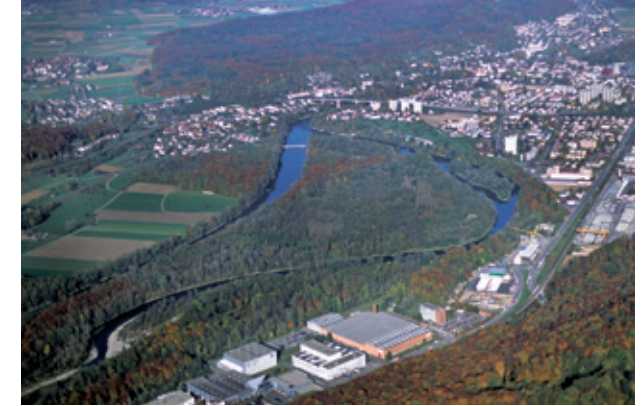
Aare bei Umiken mit Kraftwerkkanal und Seitenarm
