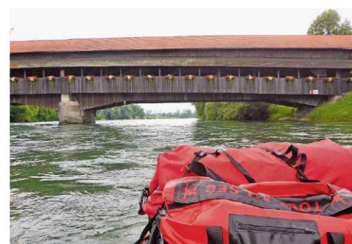
Die Sinsler Holzbrücke ist eine beeindruckende Konstruktion.
