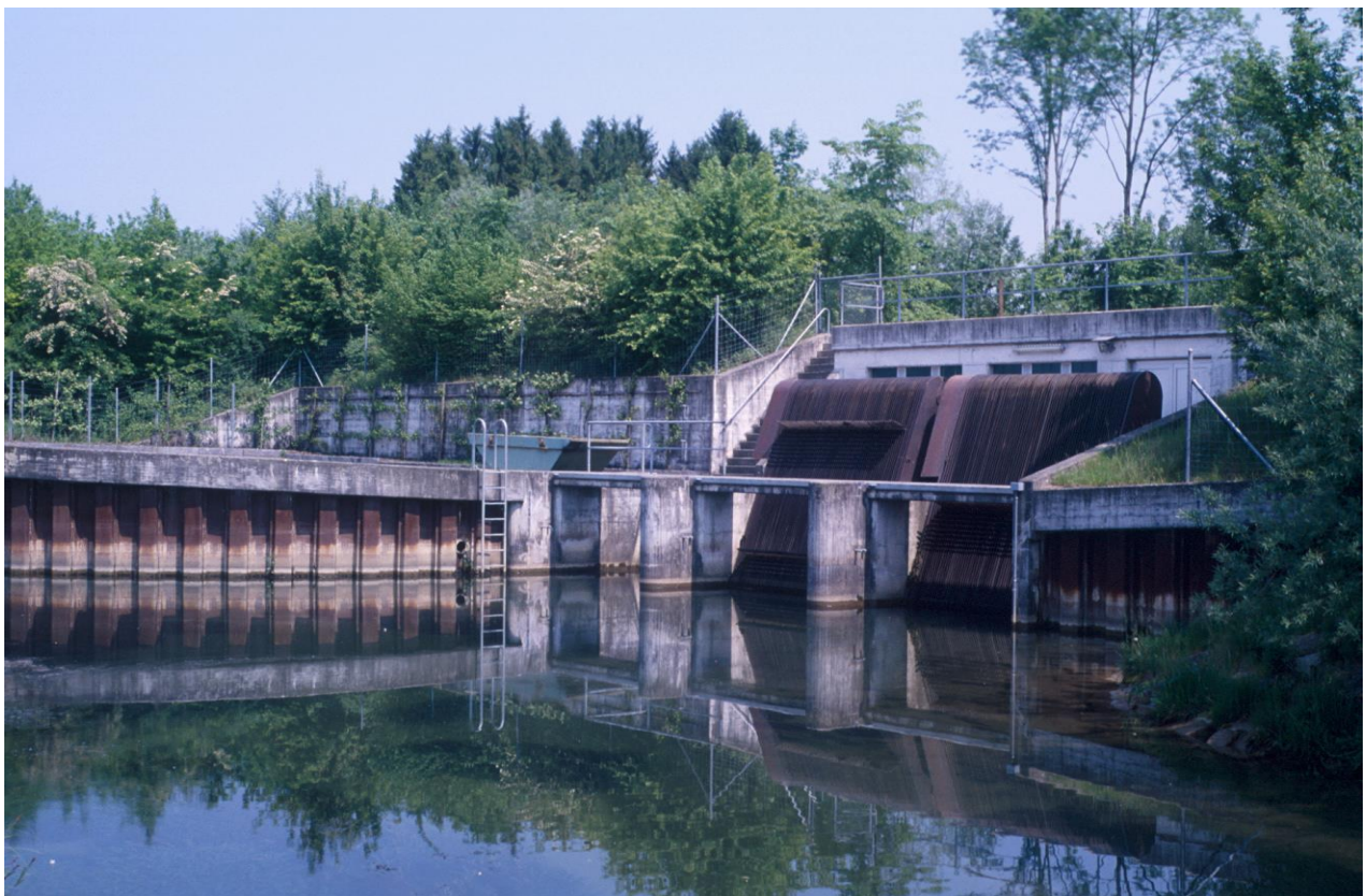
Eine der Entwässerungs-Pumpstationen in der Reussebene
