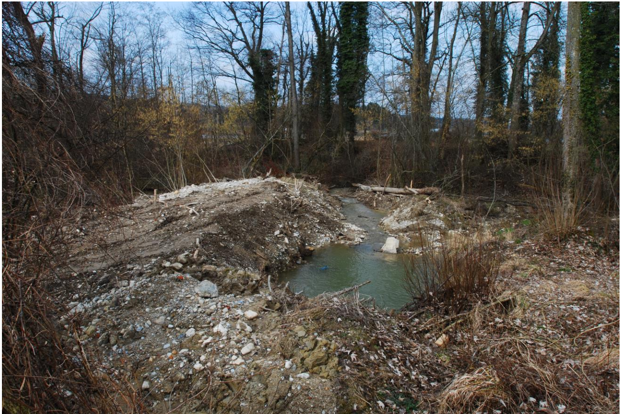
Der frisch sanierte Einlauf des Wydebachs 2009
