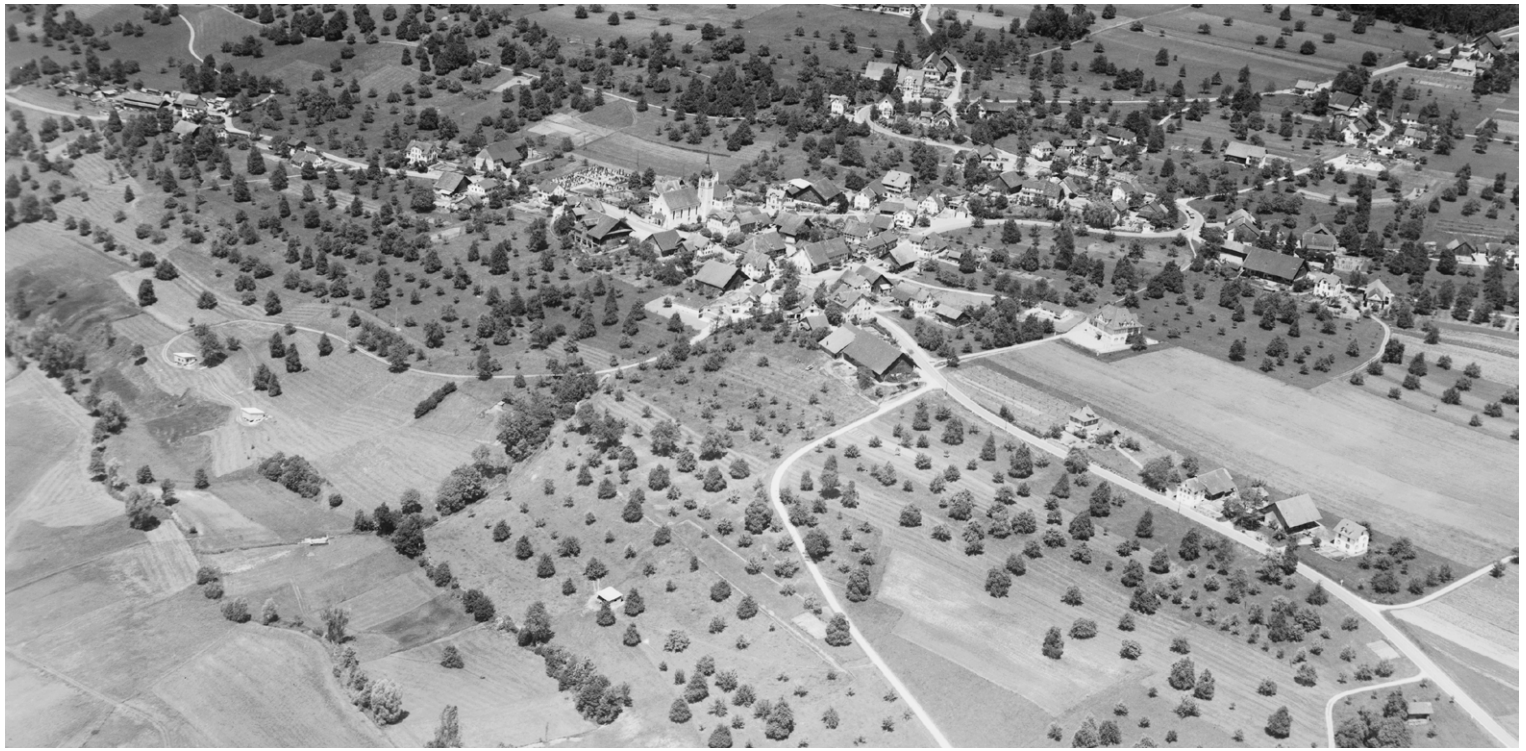
Luftaufnahme von 1962 von Oberlunkhofen. Das Hangried mit den beiden frisch erstellten Wochenend-Häuschen ist links in der unteren Bildmitte ersichtlich. Die bescheidene Strassendorfsiedlung von Oberlunkhofen ist von ausgedehnten Hochstamm-Obstgärten eingefasst. Der krasse Landschaftswandel bezüglich Überbauung und Hochstamm-Obstbäumen ist im Vergleich mit dem nahezu identischen Perimeter auf der Luftbild-Aufnahme von 2015 auf Seite 1 ersichtlich. Quelle: ETH-Bibliothek, Bild LBS_H1-022945
