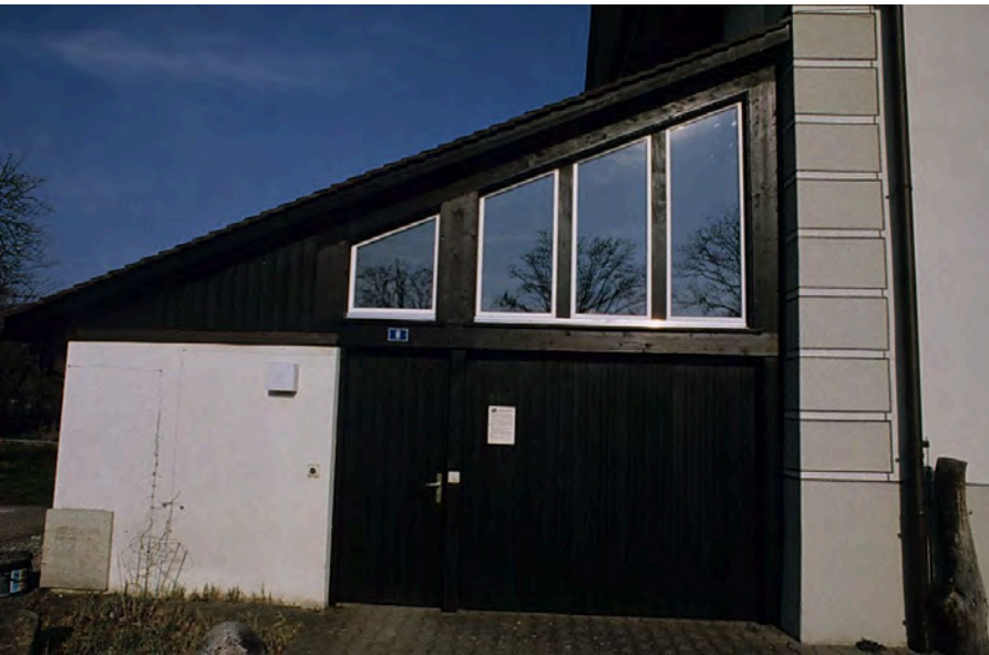
1997 Ausbau Estrich, weitere Fenster Vorbau, P
