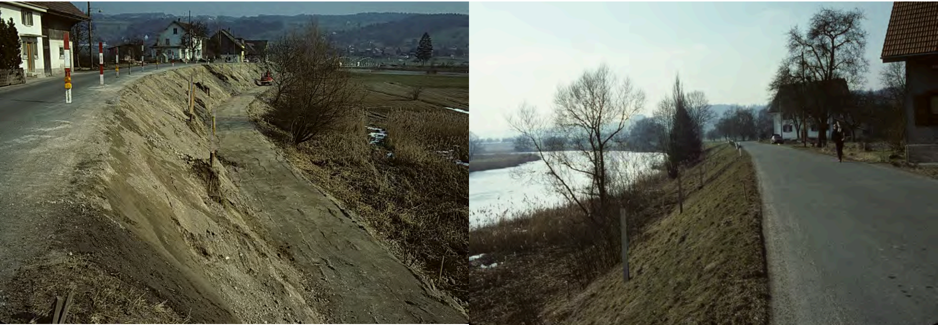
Ausbau Kantonsstrasse in Rottenschwil 1981
