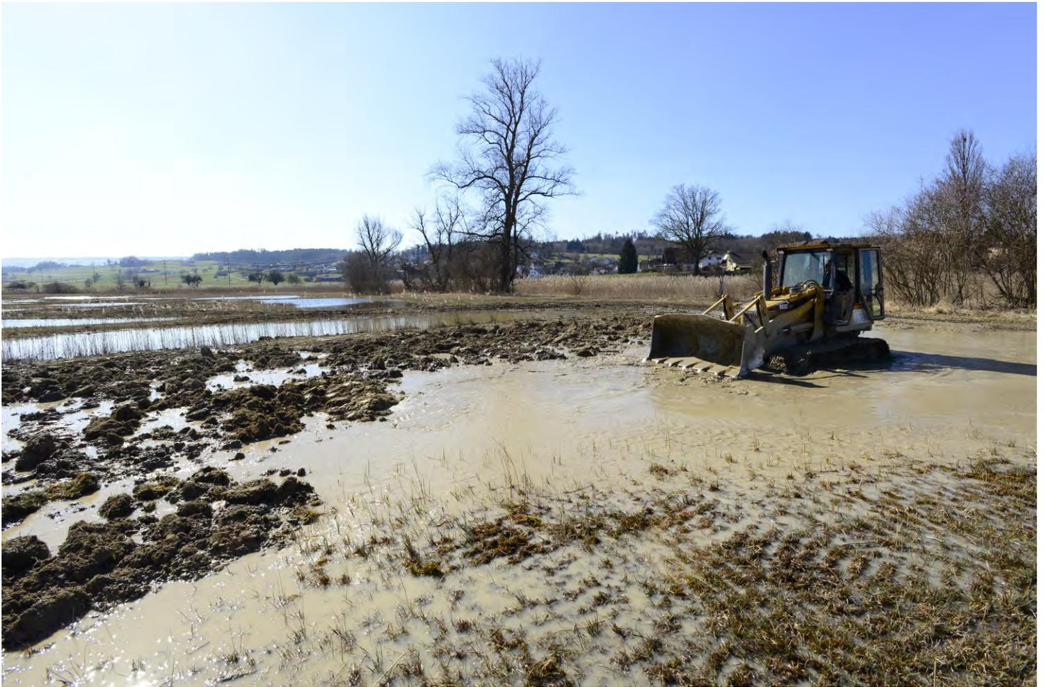
Moorraupe-Einsatz vom 12. März 2015: Das Foto oben zeigt einen teilweise frisch verfüllten Tümpel, die breiten Raupen an der Baumaschine erlaubt das Fahren im Seichtwasser. Auf dem Bild unten wird auf einer stärker bewachsenen Fläche der Oberboden abgeschürft, der für die Tümpelverfüllung verwendet wird.
