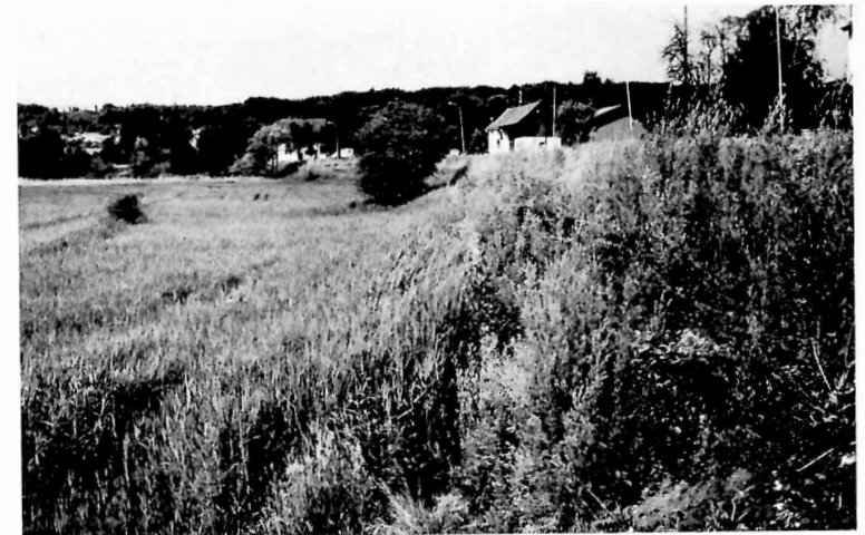
Abb. 3 Der Blick vom Parkplatz des Gasthofs zum Hecht in Richtung Zieglerhaus (Gebäude ganz links) zeigt die auf ca. 300 m Länge mit ingenieurbiologischen Mitteln gesicherte Steilböschung der Kantonsstrasse in Rottenschwil. Ganz rechts sind die üppig austreibenden Weiden des Lebendverbaus erkennbar. (Aufnahme von Juni 1982)
