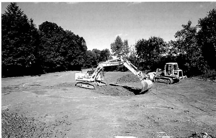
Abb.: Rüsmatten, September 1993: Der Aushub für die Amphibiengewässer beginnt. Der nährstoffreiche Oberboden (Humus) ist bereits abgetragen und weggeführt. (Foto J. Fischer)
