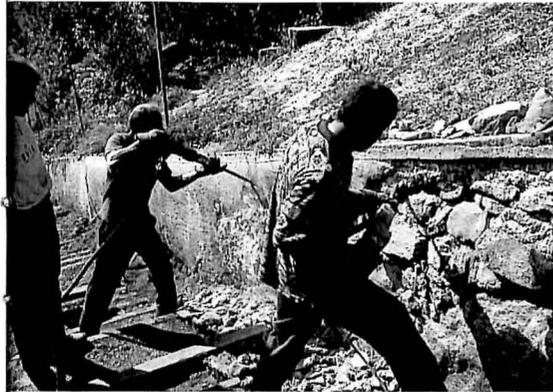
Links: Auch für Zivilschutzleute nicht alltägliche Übungsmöglichkeit: Abspitzen der «Zementfüllungen» mit dem Pressluftbohrer, ohne die darunter verborgene Bruchsteinmauer zu beschädigen.
